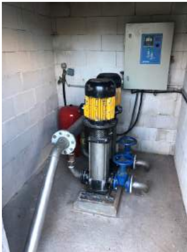
Foto 45: Cuadro eléctrico EBAL de Vilaza
