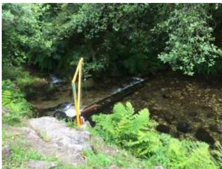
Foto 1: Azud en río de captación de Gondomar
