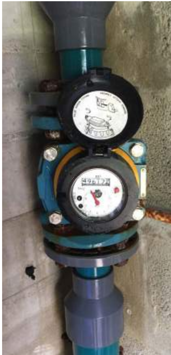
Foto 38: Contador mecánico entrada DAP Vilaza
