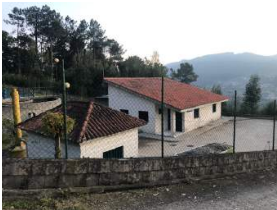
Foto 11: Vista General ETAP
