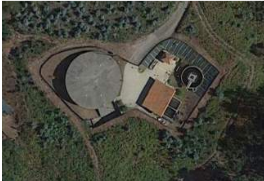
Foto 10: Foto aérea ETAP
