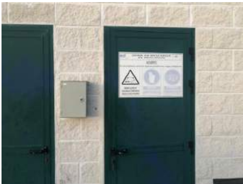
Foto 23: Acceso caseta cloro en ETAP
