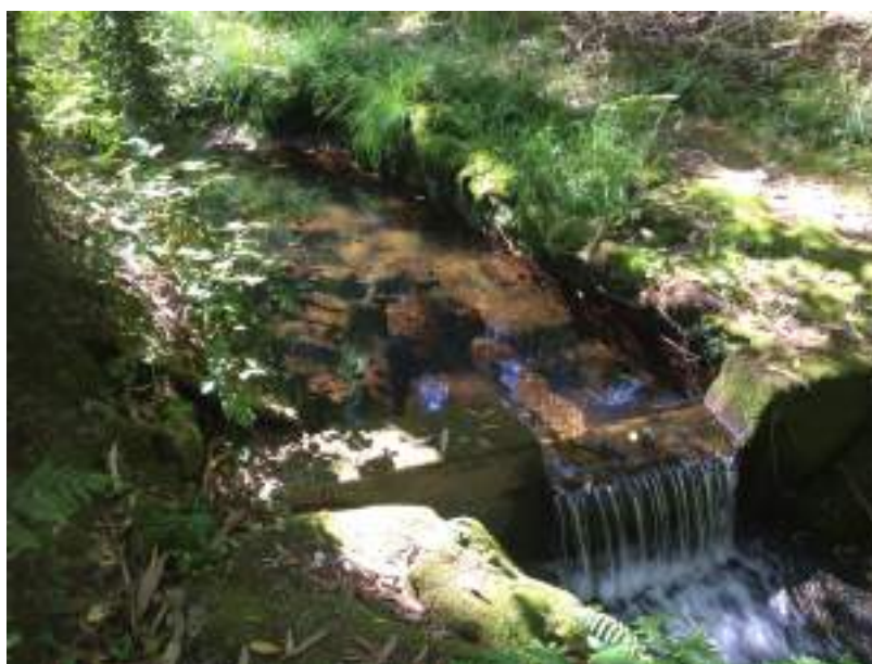
Foto 7: Azud en río de captación de Vilaza
