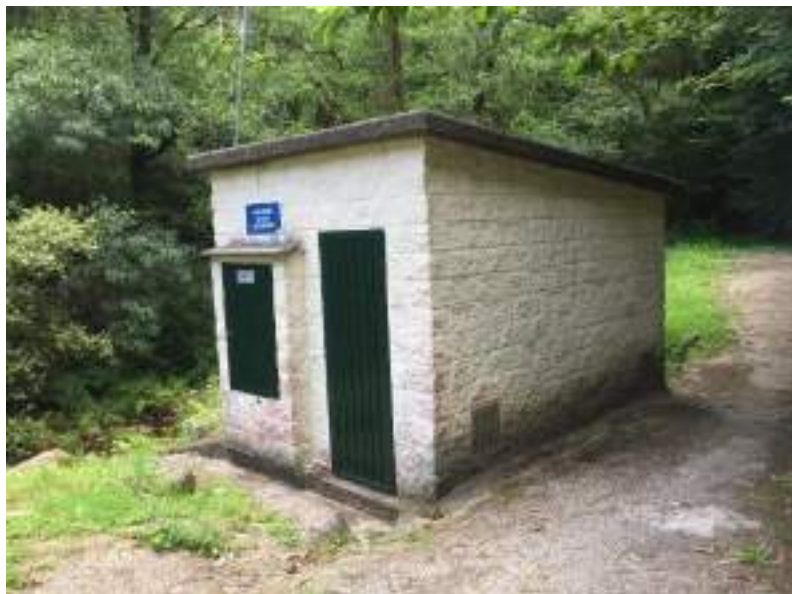
Foto 2: Exterior Caseta en pozo de bombeo de captación de Gondomar
