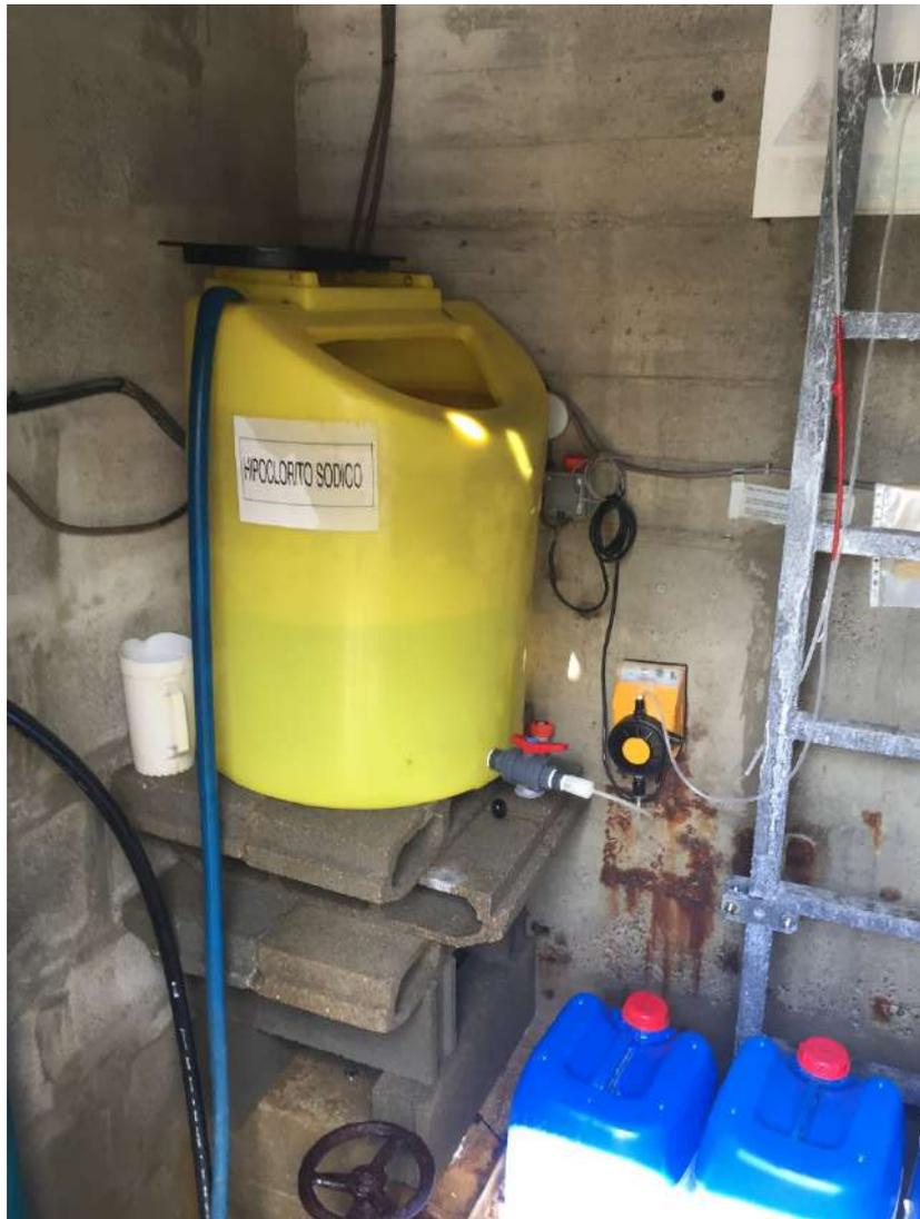
*Foto 39: Sistema dosificación depósito de Vilaza*
