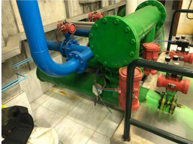
Foto 17: Salida de filtros, aire (tuberías azules) y agua lavado (colector verde) en ETAP
