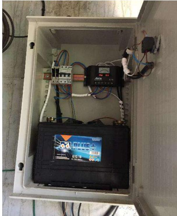
Foto 34: Sistema alimentación fotovoltaico depósito de Donas
