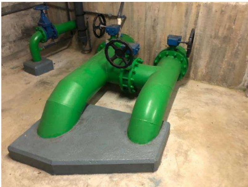
*Foto 27: Entrada (tubería derecha), salida (tubería izquierda) y bypass*
