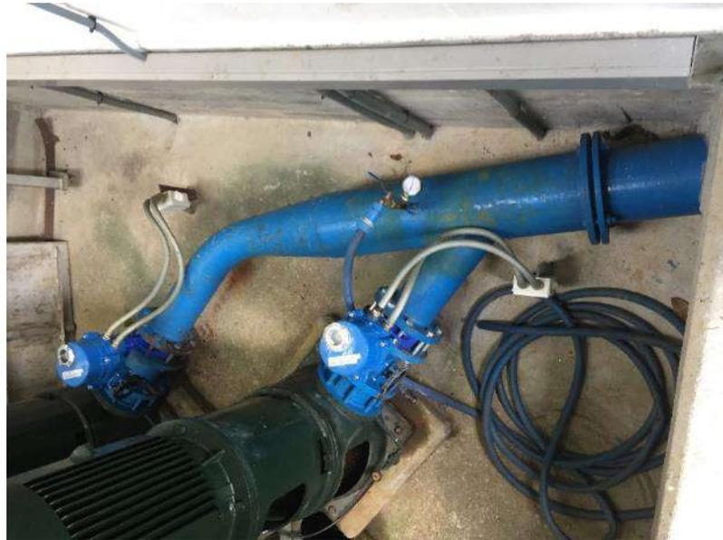
Foto 5: Colector impulsión en pozo de bombeo de captación de Gondomar
