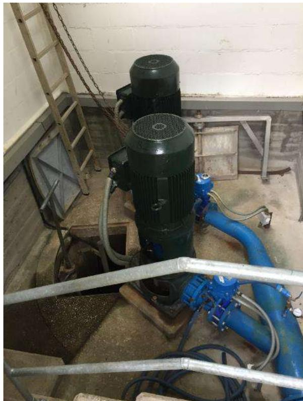
*Foto 3: Sala de Motores en pozo de bombeo de captación de Gondomar*
